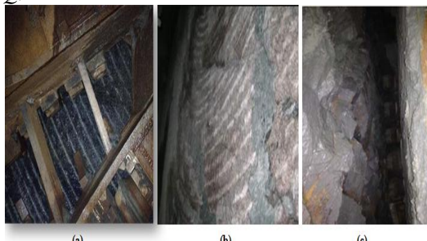
Figura 3 - Imagem das pistas de rolamento dos cortadores, fotos tiradas do interior da câmara de escavação - (a) Escavação do P.K. 12,1+30m (b) escavação do P.K. 11,9+70m (c) escavação do P.K. 11,9+05m
